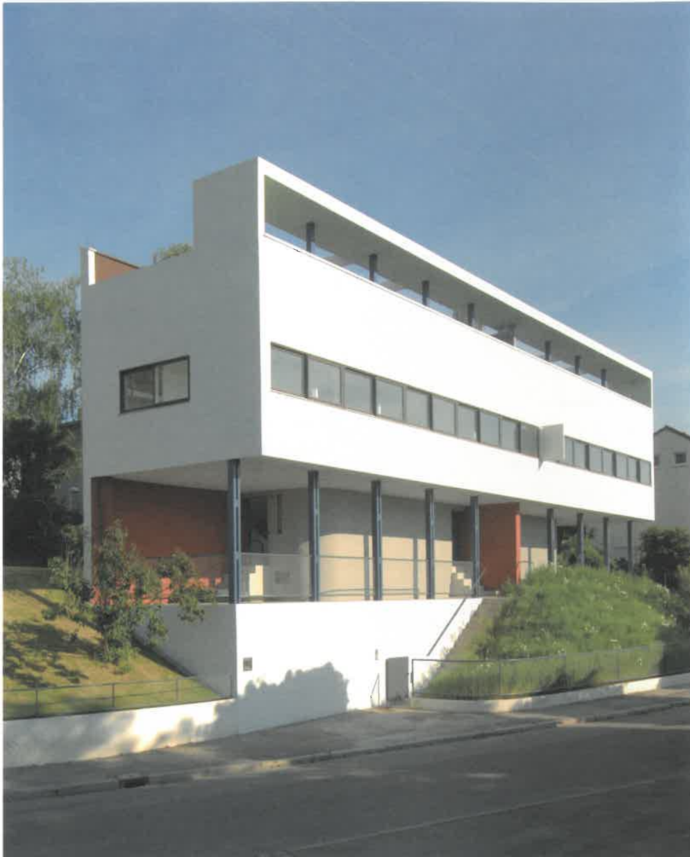
▲ Le Corbusier und Pierre Jeanneret, Doppelhaus, Straßenansicht, 2006 / Le Corbusier and Pierre Jeanneret, semi-detached houses, street view, 2006
