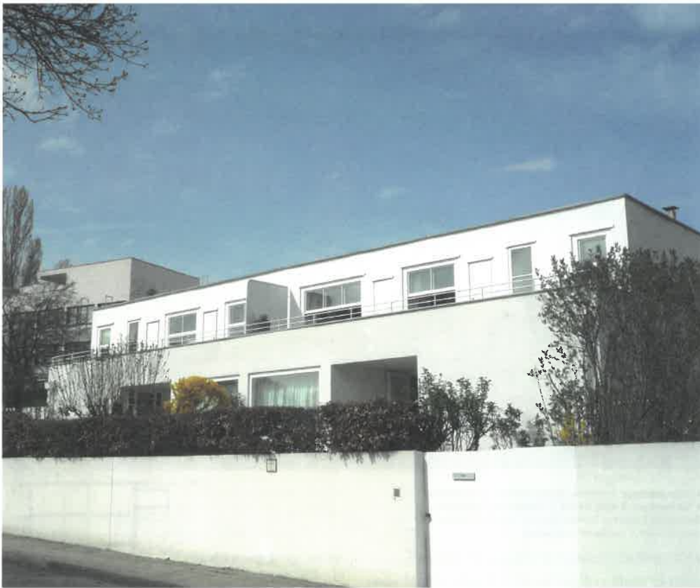
▲ Haus Frank, Straßensicht, 2016 / Frank Houses, street view, 2016
