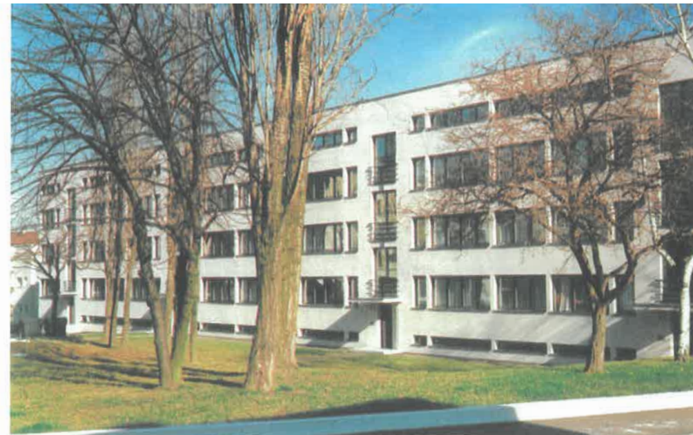
▲ Eingangsseite, 1989 / entrance view, 1989
