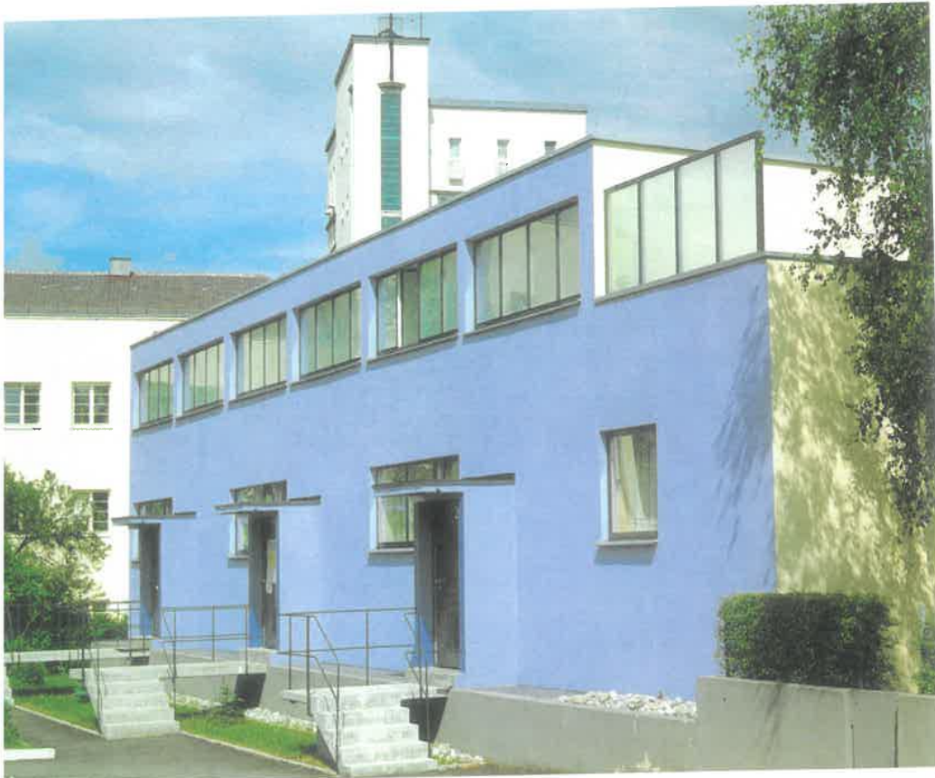
Haus Stam, Eingangsseite, 1989 / Stam Houses, entrance view, 1989
