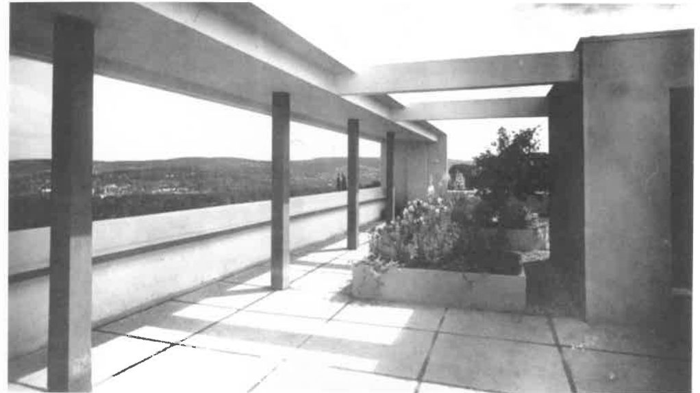
▲ Die beiden Häuser von Le Corbusier und Pierre Jeanneret, 1927 / The houses from Le Corbusier and Pierre Jeanneret, 1927
